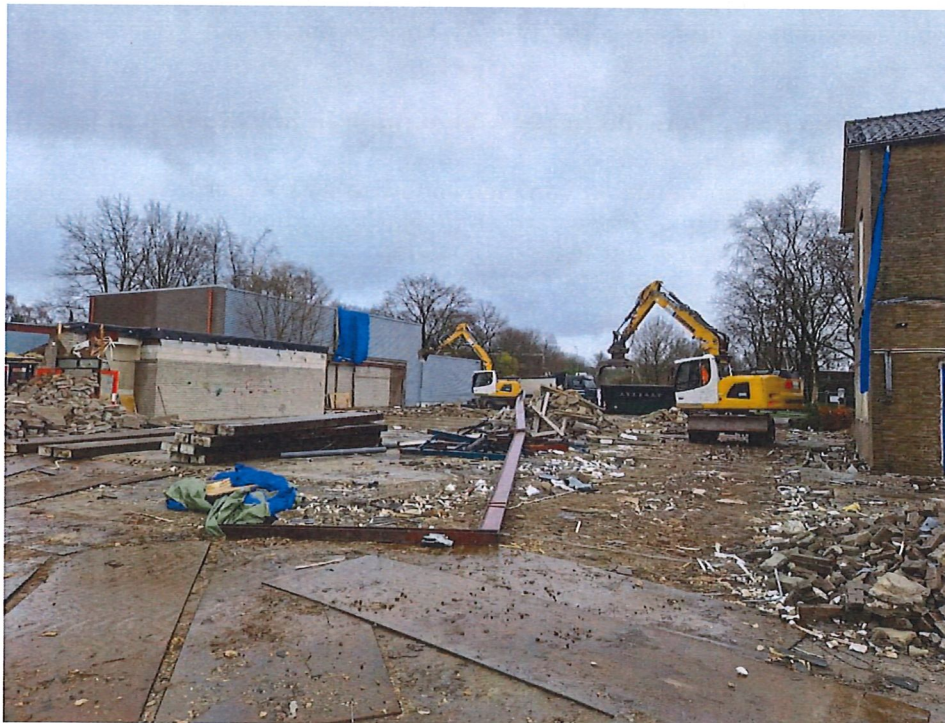
Figuur 2: Sloop ten behoeve van Margrietschool Wageningen
